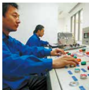
Экспериментальная станция 110 кВ
