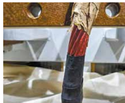
Соединение холодным прессованием и степень заполнения более 85 %.
